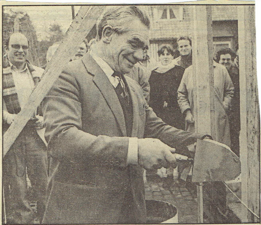
● Kees Swaanen plaatst een gedenksteen in de in aanbouw zijnde dorpspomp.
