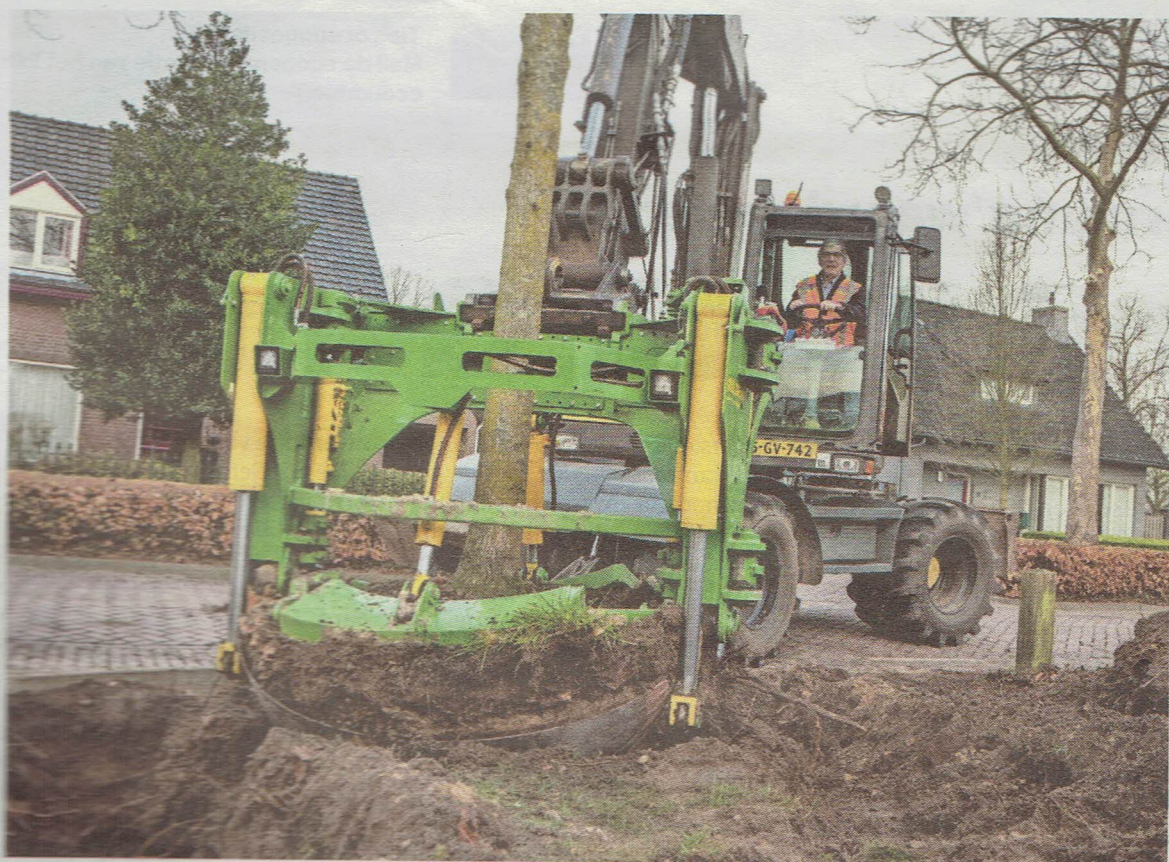
▲ Straten in Hoogeloon gaan op de schop voor de vernieuwing van de riolering. De officiële aftrap werd gedaan door wethouder Wim van der Linden. FOTO JEAN PIERRE REIJNEN/DCI MEDIA
